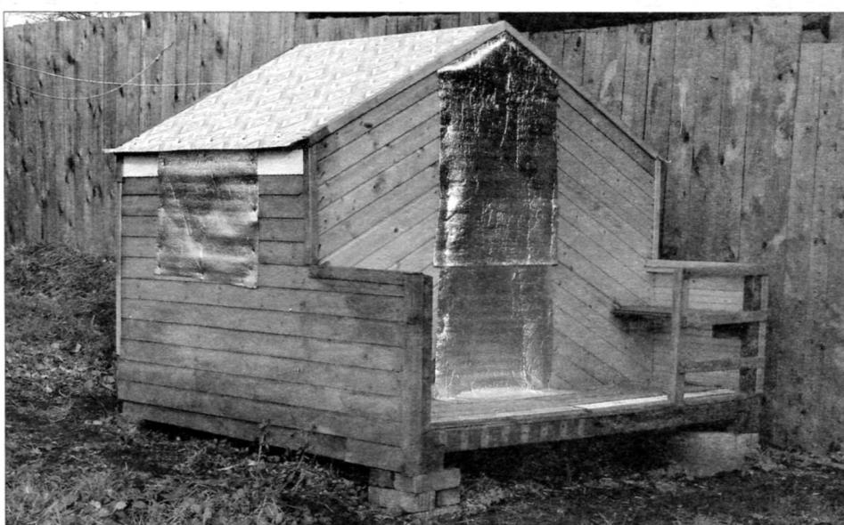
Поскольку окна и входной проём открыты всем ветрам, то на зиму «законсервировал» домик обрезками теплоизоляции ISOVER (из минеральной ваты на стекловолокне и покрытой алюминиевой фольгой), оставшимися после строительства бани
