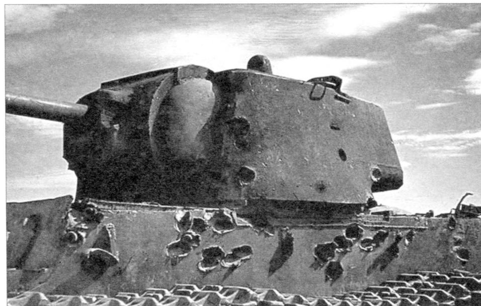
Башня КВ-2 со следами многочисленных попаданий. Однако снаряды немецких противотанковых пушек 47-мм Pak 36(t), 50-мм Pak 38 не могли причинить ей особого вреда. Опасны были лишь 88-мм снаряды зениток Flak 18
