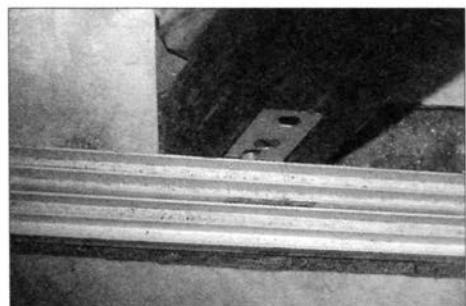
Нижний горизонтальный брус «утоплен» в стяжке пола ванной комнаты и крепится к стойке при помощи уголка
