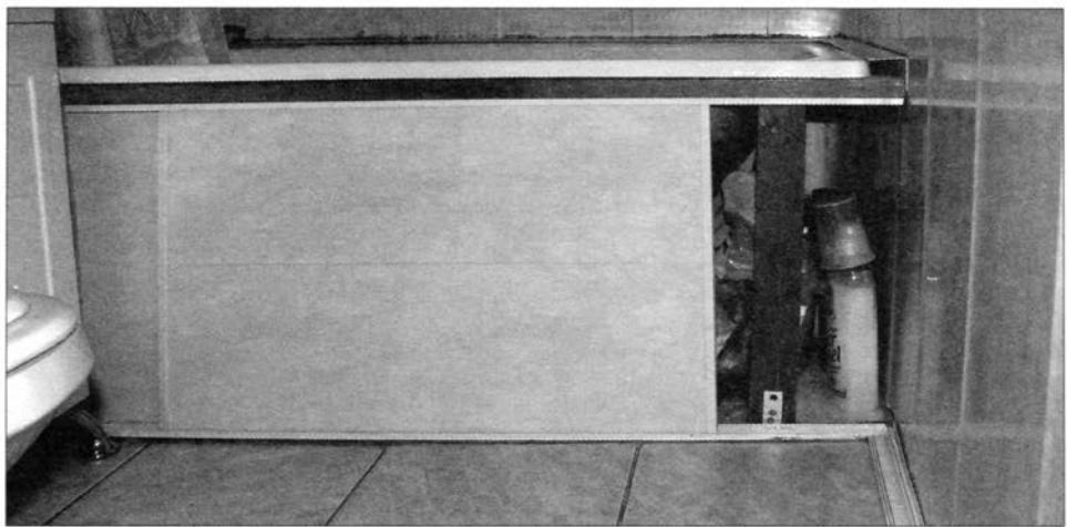
(с внутренней стороны) непосредственно шурупами, а с нижним – с помощью алюминиевого уголка (он меньше подвержен коррозии, чем стальной). Чтобы деревянная рама каркаса не «болталась», при креплении верхний брусок прижал к ванной с небольшим усилием.
